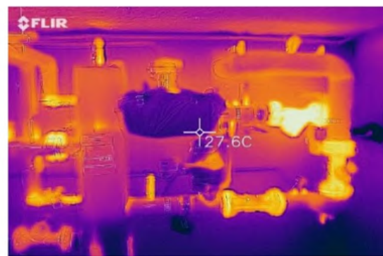
Isolation des points singuliers et photos d'une caméra thermique (avec et sans coussin)
