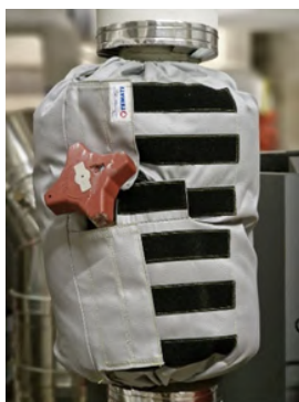
Isolation des points singuliers et photos d'une caméra thermique (avec et sans coussin)
