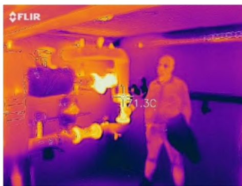
Isolation des points singuliers et photos d'une caméra thermique (avec et sans coussin)
