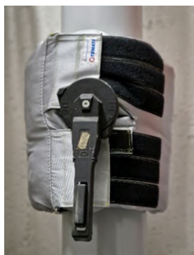
Isolation des points singuliers et photos d'une caméra thermique (avec et sans coussin)
