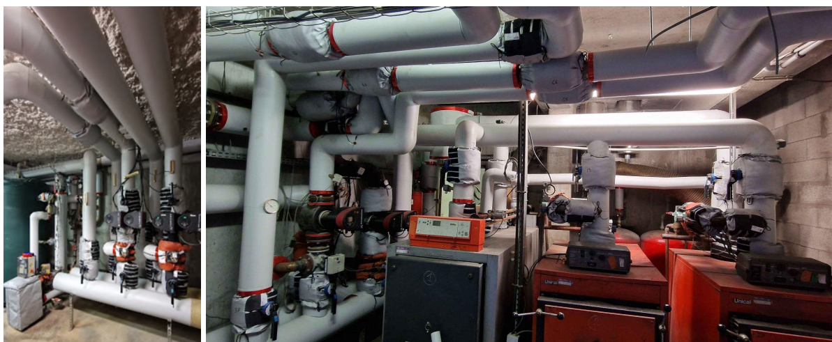
Parking et chaufferie
